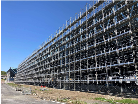
受入貯留ヤード 足場組立状況
