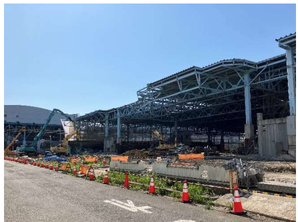
受入貯留ヤード 躯体解体状況
