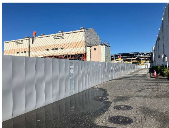
仮囲い設置状況
