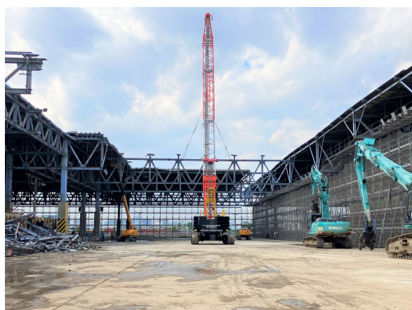
受入貯留ヤード 躯体解体状況
