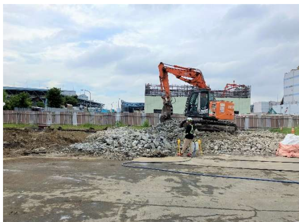
倉庫・修理棟 土間基礎解体状況
