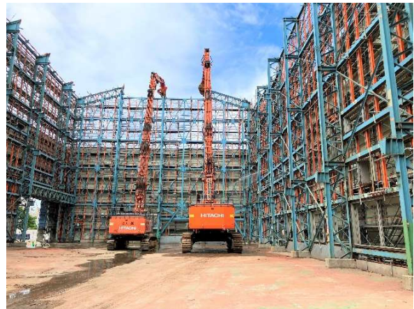
選別棟 躯体解体状況
