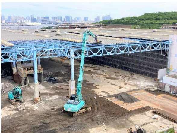
受入貯留ヤード 屋根解体状況
