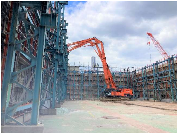
選別棟 躯体解体状況
