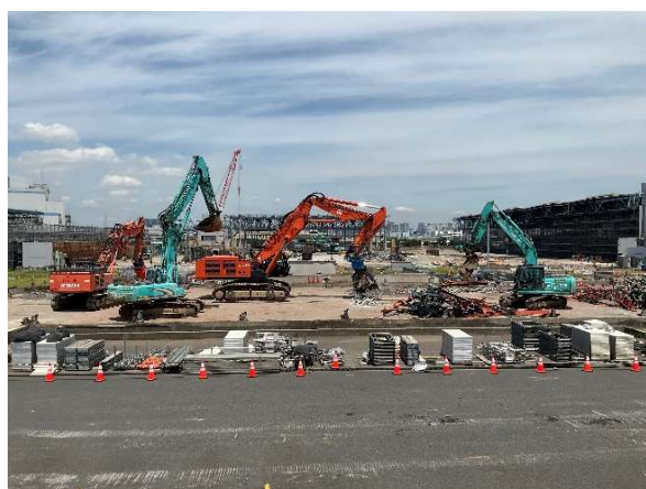
選別棟 土間基礎解体状況
