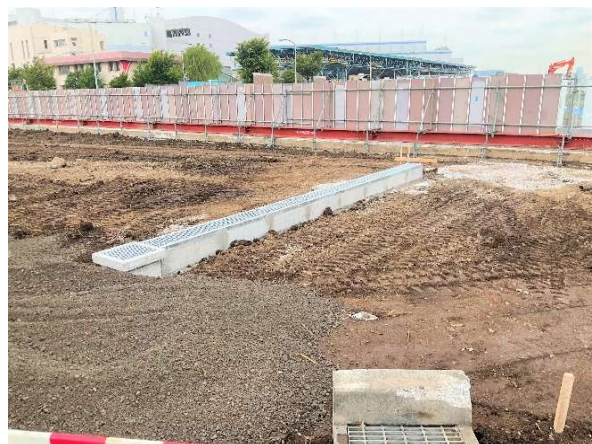
仮設排水側溝設置状況
