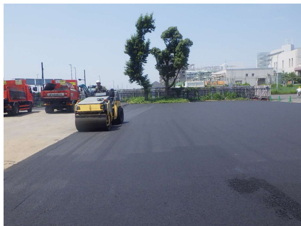
倉庫・修理棟 仮設舗装状況
