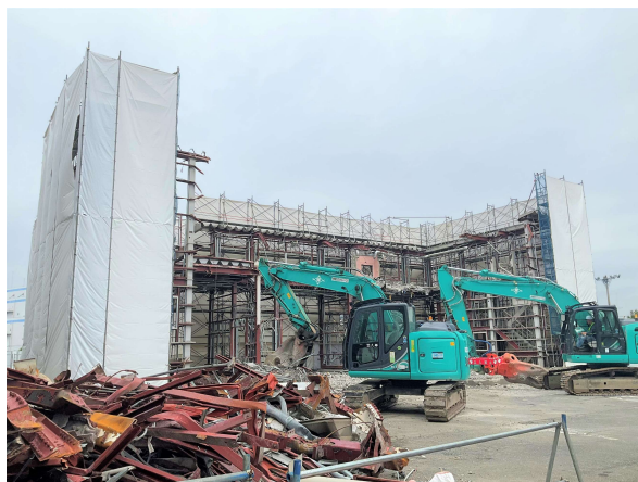
不燃ゲート 躯体解体状況
