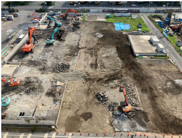
選別棟 土間基礎解体状況
