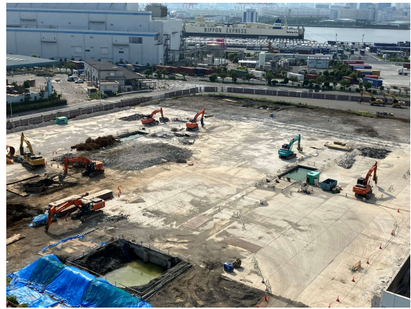
受入貯留ヤード 土間基礎解体状況
