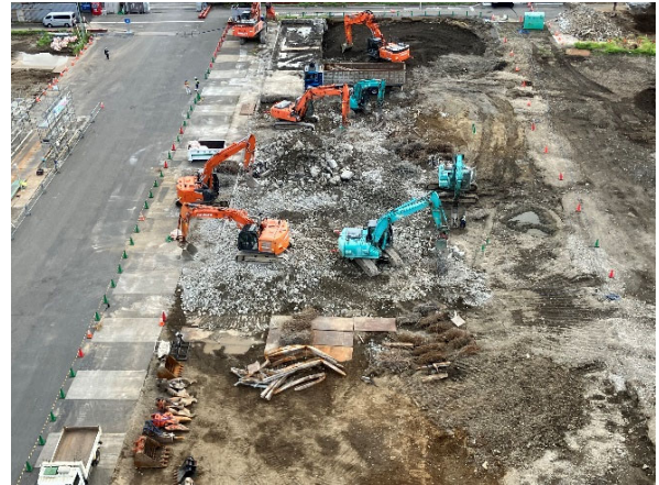
コンテナヤード 土間解体状況
