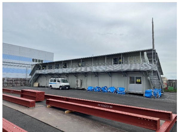
現場事務所 組立完了状況
