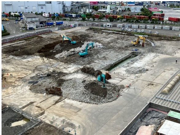
受入貯留ヤード 土間基礎解体状況
