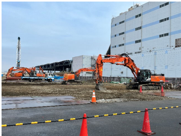
アスファルト撤去状況
