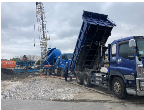
選別棟 流動化処理土打設状況
