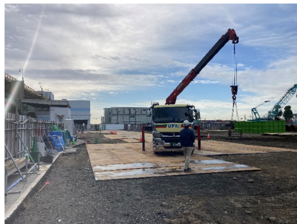
場内通路 敷鉄板整備状況
