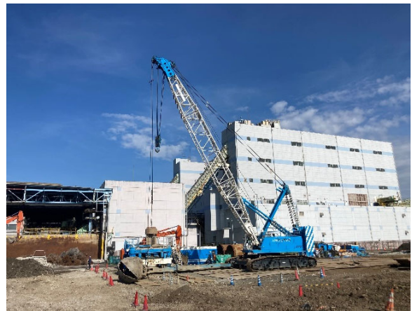
東側破碎機 基礎解体状況
