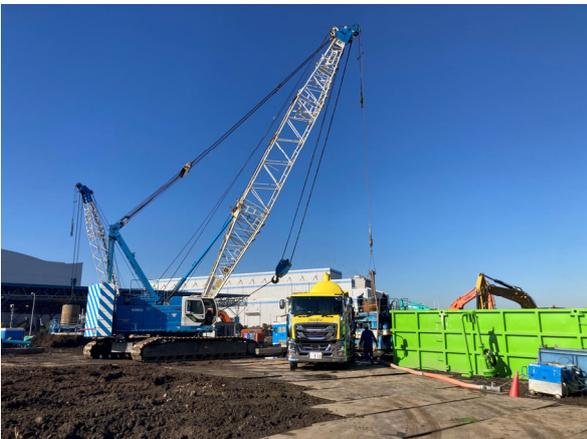
東側破碎機基礎 流動化土打設状況
