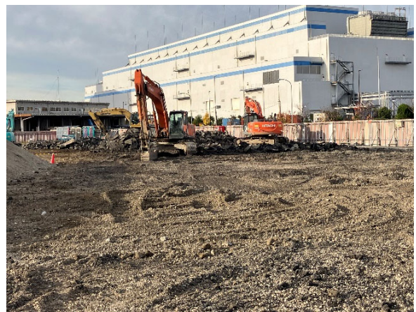
北側車路 アスファルト撤去状況
