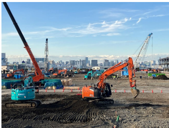
敷地南側 地盤改良工事状況
