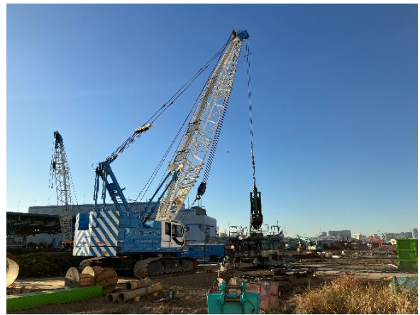
破碎機基礎 既存杭撤去状況
