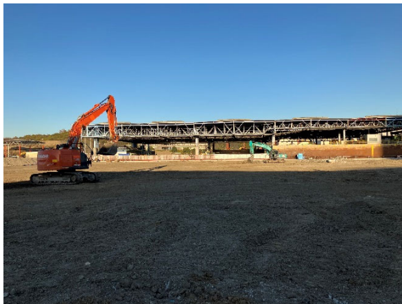
受入貯留ヤード 整地状況
