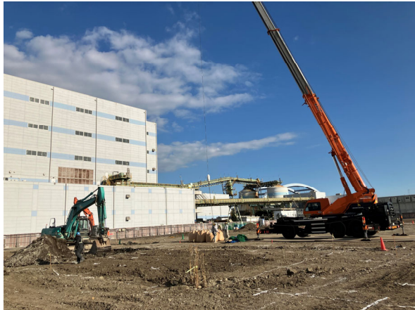
受入貯留ヤード 地盤改良状況
