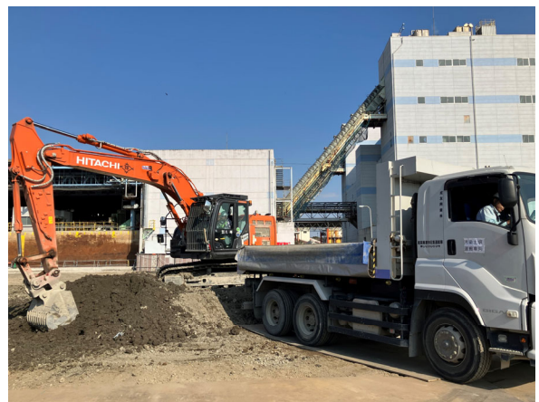
破碎処理棟 汚染土搬出状況
