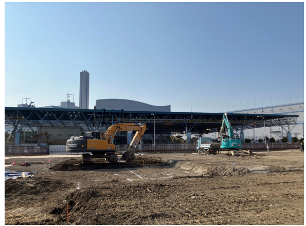
破碎処理棟 地盤改良状況
