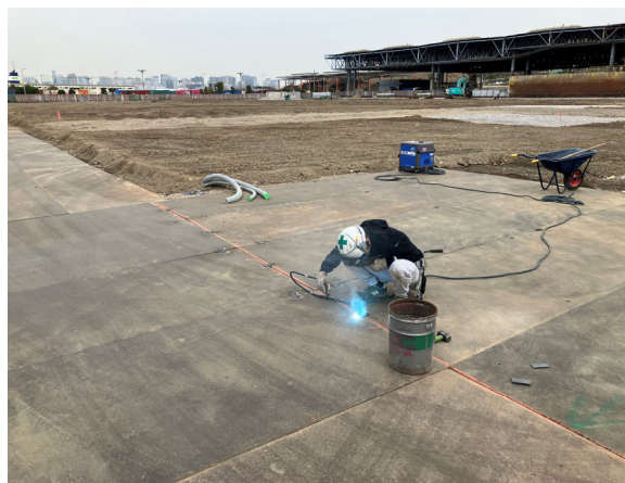
西側車路 敷鉄板溶接状況
