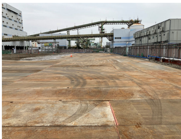
南側車路 敷き鉄板整備状況
