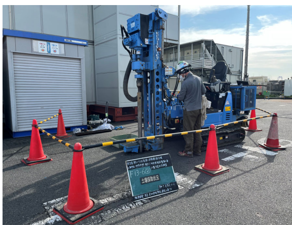
土壌汚染調査状況
