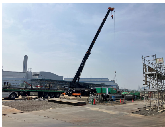
選別処理棟 杭打機部材搬入状況
