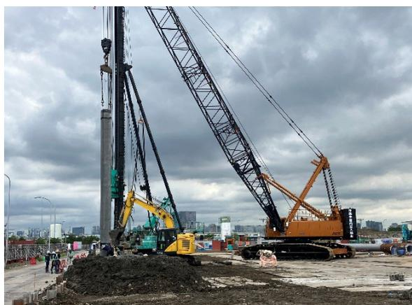
受入貯留ヤード棟 既成杭打設状況
