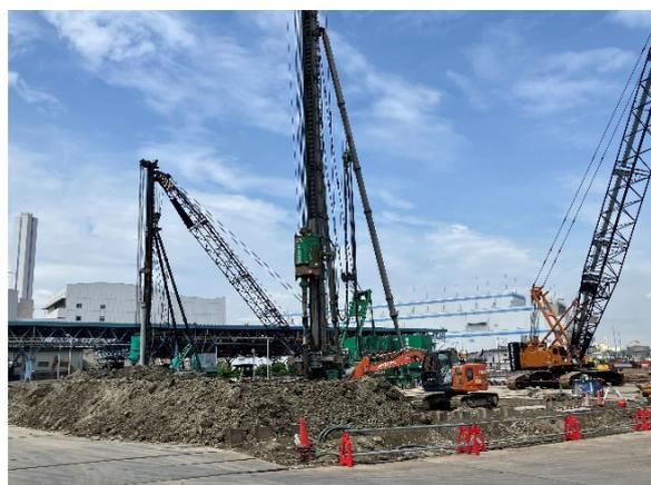
破砕処理棟 既成杭打設状況
