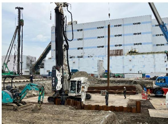
選別処理棟 シートパイル打設状況
