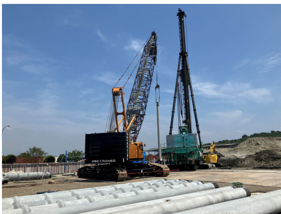
第一計量棟 既製杭打設状況
