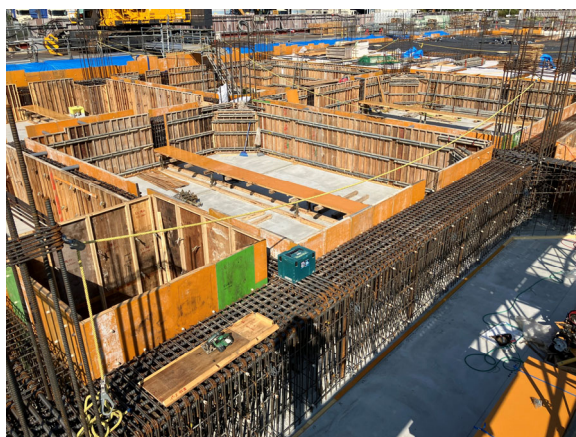
選別処理棟 基礎型枠建込状況
