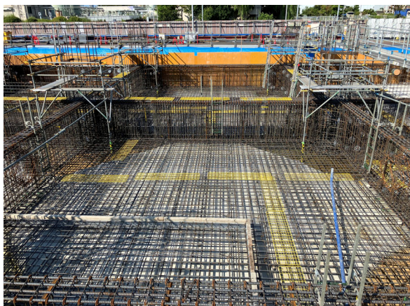
選別処理棟 捨てCON打設状況
