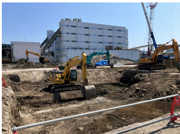
受入貯留ヤード棟 一次根伐施工状況
