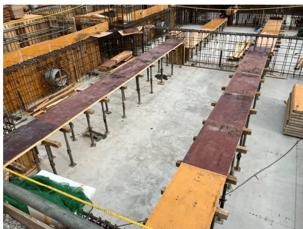
選別処理棟 型枠建込状況
