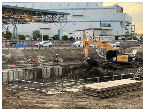
受入貯留ヤード棟 一次根伐状況
