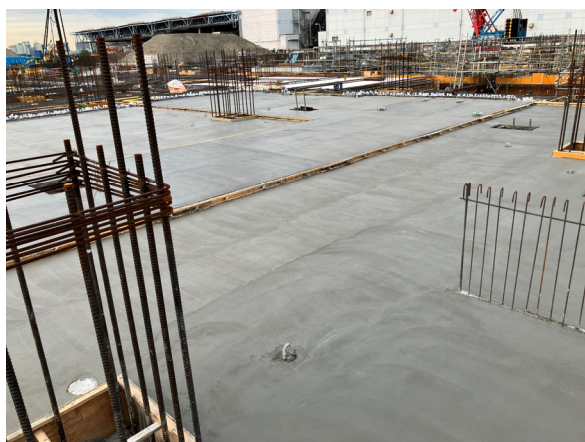
選別処理棟 1階床CON打設状況
