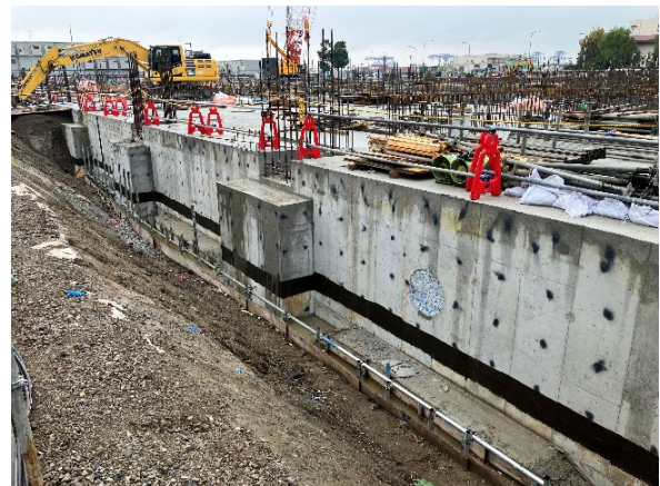
選別処理棟 外周部塗布防水施工状況
