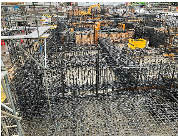
破碎処理棟 基礎配筋状況
