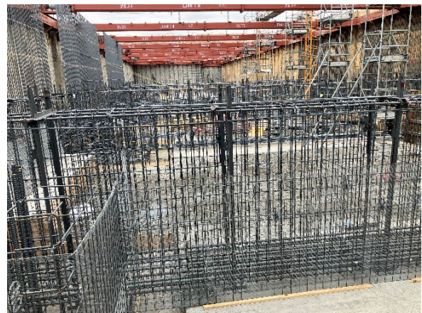
受入貯留ヤード棟 ピット基礎配筋状況
