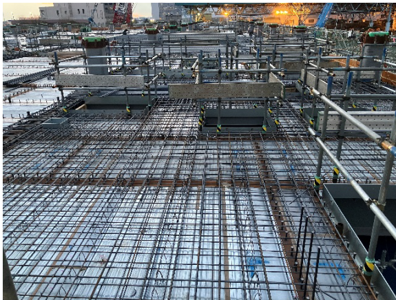
選別処理棟 2階床配筋状況
