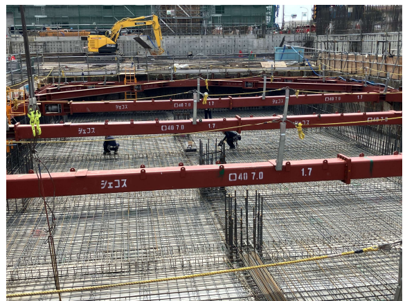
受入貯留ヤード棟 B1階スラブ配筋状況
