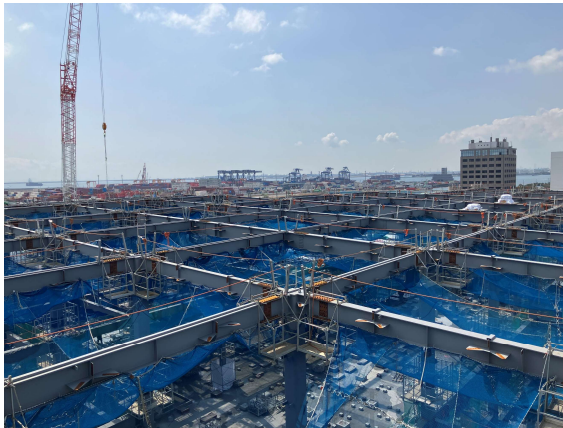
選別処理棟 屋根鉄骨建方状況
