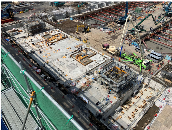
破砕処理棟 基礎CON打設状況
