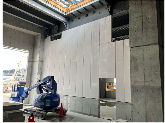
選別処理棟 1階ALC施工状況
