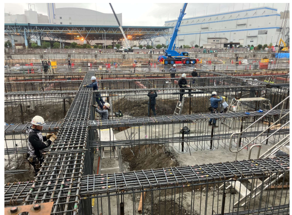
受入貯留ヤード棟 1階基礎配筋状況
