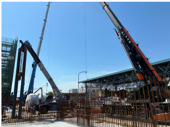
受入貯留ヤード棟 H鋼引抜状況
