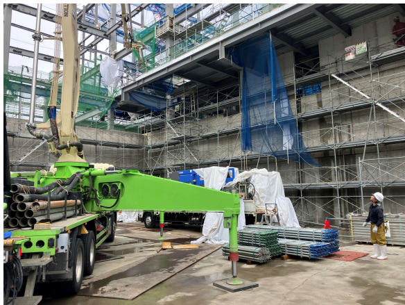
選別処理棟 3階床CON打設状況
