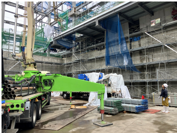
選別処理棟 3階床CON打設状況
