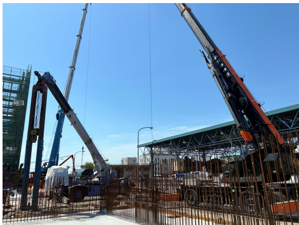
受入貯留ヤード棟 H鋼引抜状況
