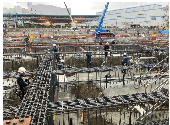
受入貯留ヤード棟 1階基礎配筋状況
