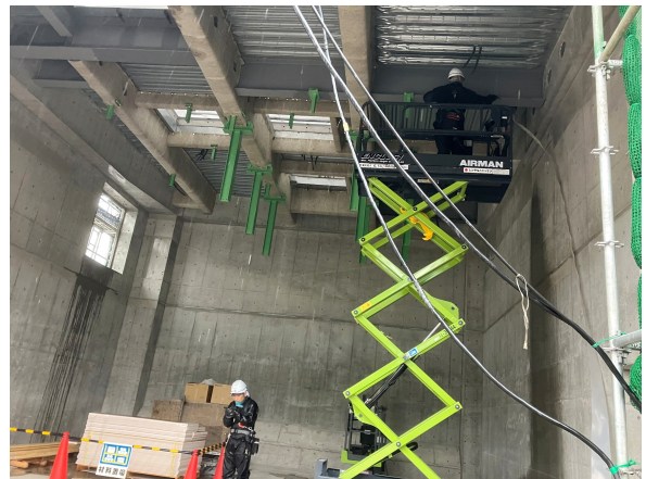
選別処理棟 耐火被覆施工状況
