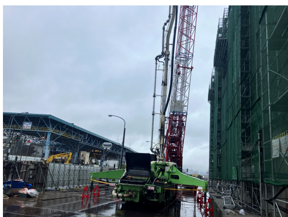
選別処理棟 4階打設状況
