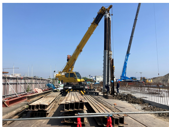
受入貯留ヤード棟 山留引抜状況
