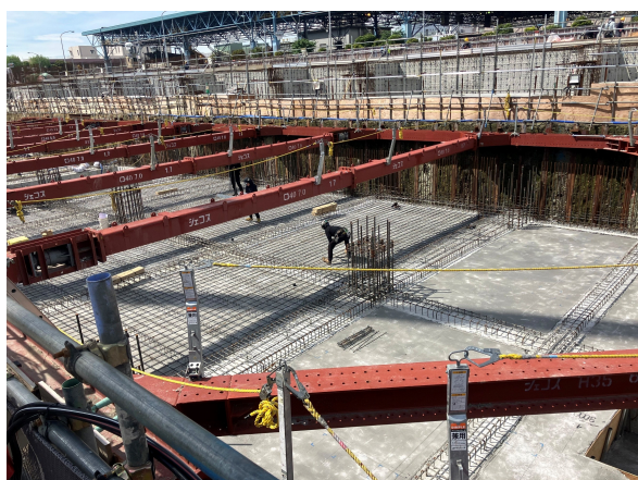
受入貯留ヤード棟 B1階床配筋状況
