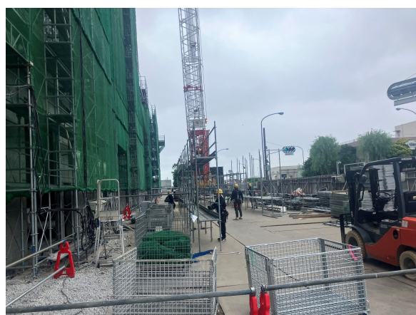
選別処理棟 外部足場解体状況
