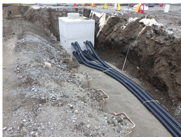
ハンドホール設置状況
