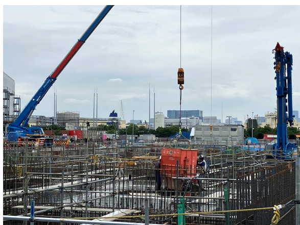
受入貯留ヤード棟 基礎埋め戻し状況
