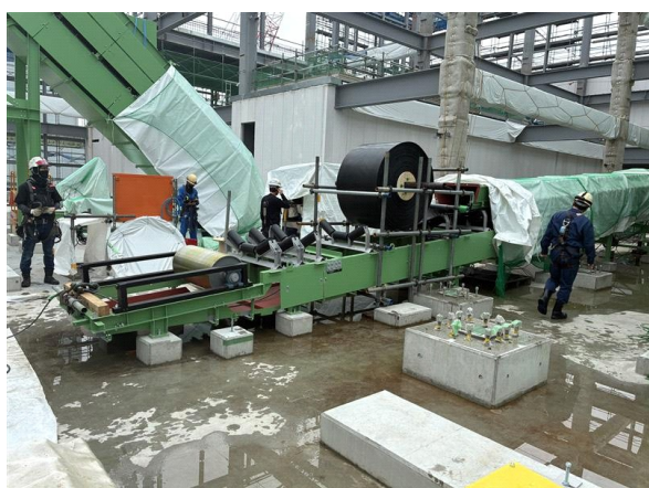
選別処理棟 コンベヤゴム挿入状況
