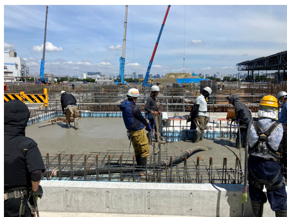
破碎処理棟 排水水槽底版コン打設状況
