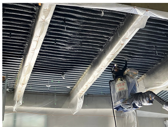
選別処理棟 1階天井ウレタン吹付状況
