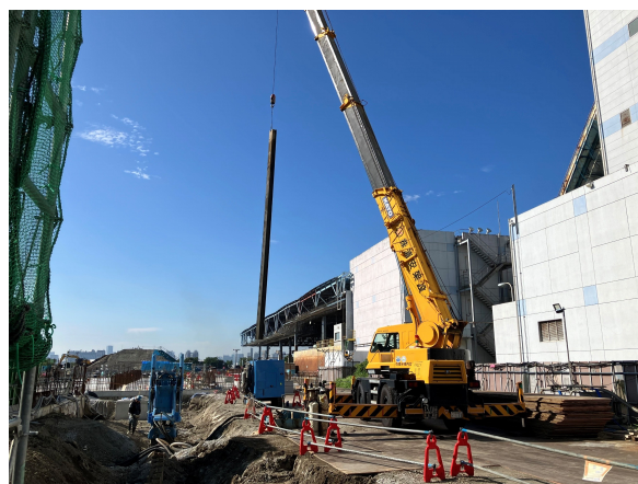
シートパイル引抜状況
