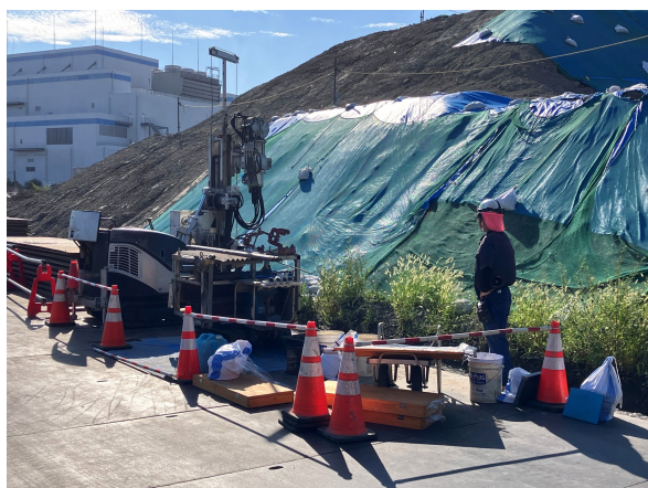
土質試験土壌採取状況
