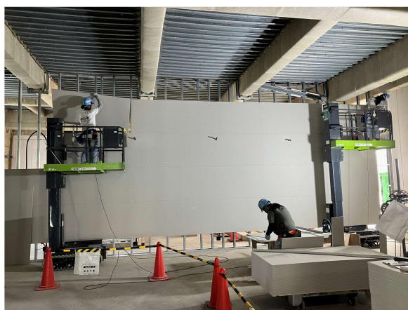
選別処理棟 区画壁ボード貼状況
