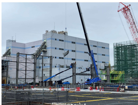
受入貯留ヤード棟 鉄骨建て方状況
