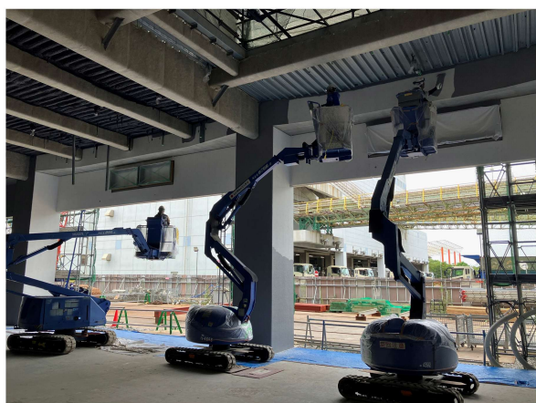
選別処理棟 梁塗装状況
