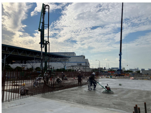
受入貯留ヤード棟 1階床コン打設状況
